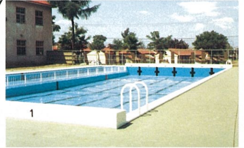
帯広市立緑ヶ丘小学校(北海道)
